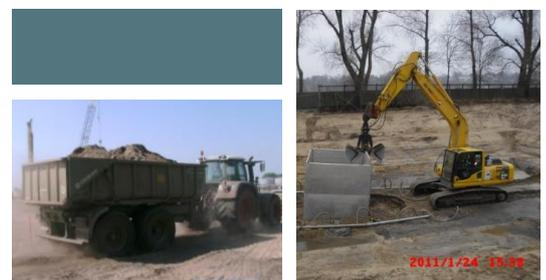
Bodenabtrag/-transport sowie Verdachtspunktbergung mittels Senkkasten
