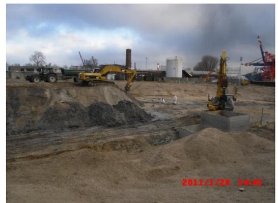
Eingesetzte Maschinen beim lagenweisen Bodenabtrag und Verdichtung
